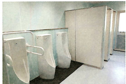
小学校のトイレの改修
