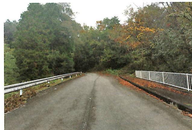
市道水洗中学校線整備済の北端
