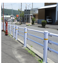
瑞浪小学校の通学路に ガードパイプの設置
